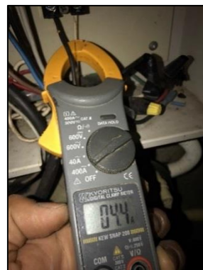
รูปที่ 3-17 การเช็คตู้คอนโทรลกระแสไฟปั้มน้ำบาดาล
