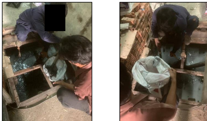
รูปที่ 3-21 เจ้าหน้าที่ชุดลอกและทำความสะอาดท่อระบายน้ำ
