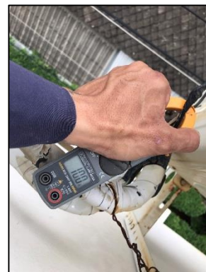
รูปที่ 3-13 เจ้าหน้าที่ทำความสะอาดและตรวจเช็คเครื่องปรับอากาศ
