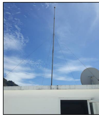
รูปที่ 3-34 ระบบป้องกันอันตรายจากฟ้าผ่า
