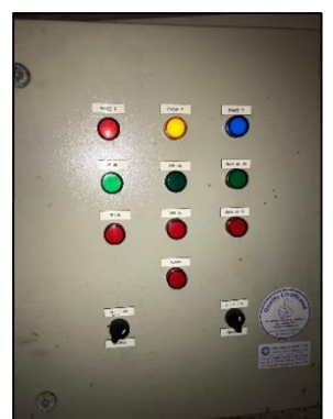
รูปที่ 3-17 การเช็คตู้คอนโทรลกระแสไฟปั้มน้ำบาดาล
